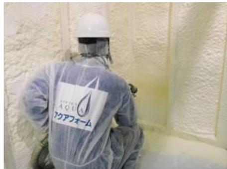
アクアフォームは住宅の隅から隅まで家全体をすっぽり覆ってしまう現場吹き付け発泡による断熱工事です。透湿性も低く断熱材内部に湿気を通しにくいいため、壁体内の結露を抑制し、建物の耐久性を高めます。
